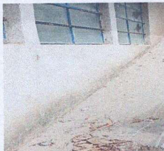
Foto 6: Repello mas cernido mas impermeabilizante mas pintura en paredes
