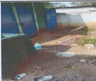
Foto1: INSTALACIÓN DE LOSA DE PATIO
