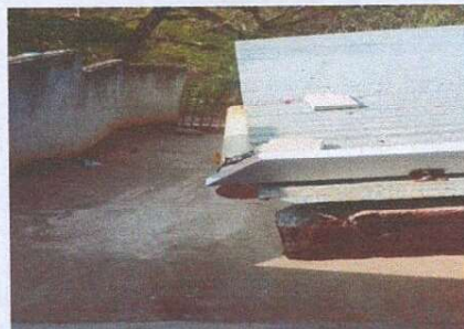
Foto 4: Instalacion de canales de pvc con bajadas mas drenajes de desfogue.
