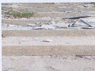
Foto 2: REPARACION DE GRADAS DE CONCRETO
