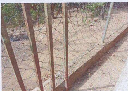
Foto 3: SUSTITUCIÓN DE MALLA CICLONICA
