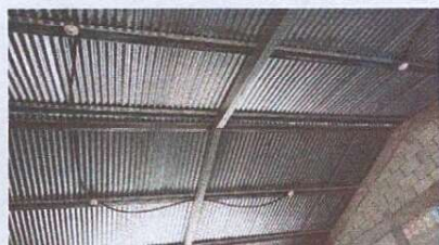
Foto1: Reparacion del sistema electrico
