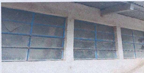
Foto 5: sustitucion de 5 ventanas de metal por pvc blanco
